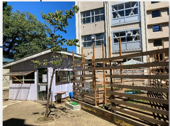
修繕された動物飼育小屋と柵
